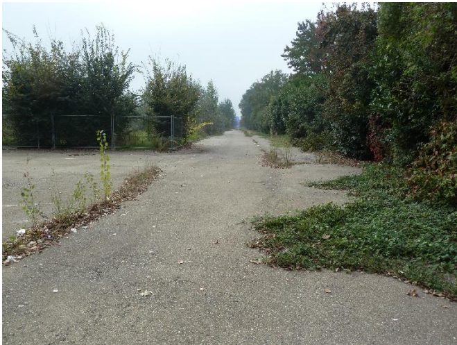
Strada principale d'accesso – le pendenze verso il centro, forse per risparmiare le caditoie laterali, ha in realtà comportato ristagni d'acqua e gelività disgreganti il manto bituminoso, favorendo la crescita di erbe infestanti.
