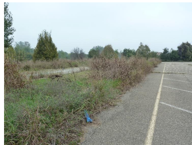
dalla 4' trasversale verso nord – a Sx la strada longitudinale secondaria: si noti la tesata aerea di alimentazione dei pali di illuminazione, mentre erano previsti cavidotti interrati - a Dx la strada esterna con parcheggio in cui risulta evidente il dislivello tra la strada e le travi di sostegno dei moduli.
