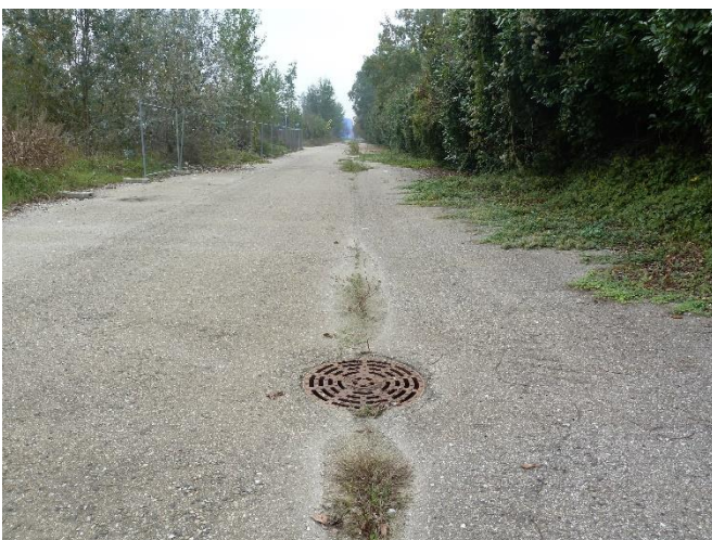
poco più avanti – si notano gli alti pioppi sempre della quadra centrale a Sx e l'affetto del compluvio centrale nella strada con il manto disgregato
