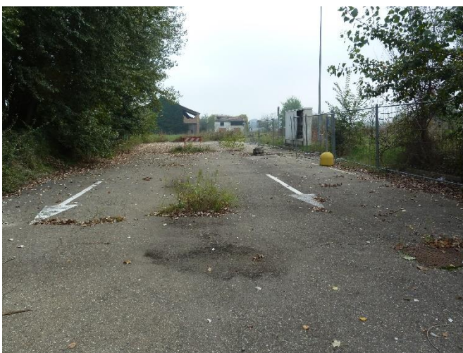
Parte finale della 1' traversa a nord – notare crescita piante entro i tombini e reti comunali residue – a Sx le piante cresciute entro la vasca di laminazione che ne rendono impossibile la manutenzione.
