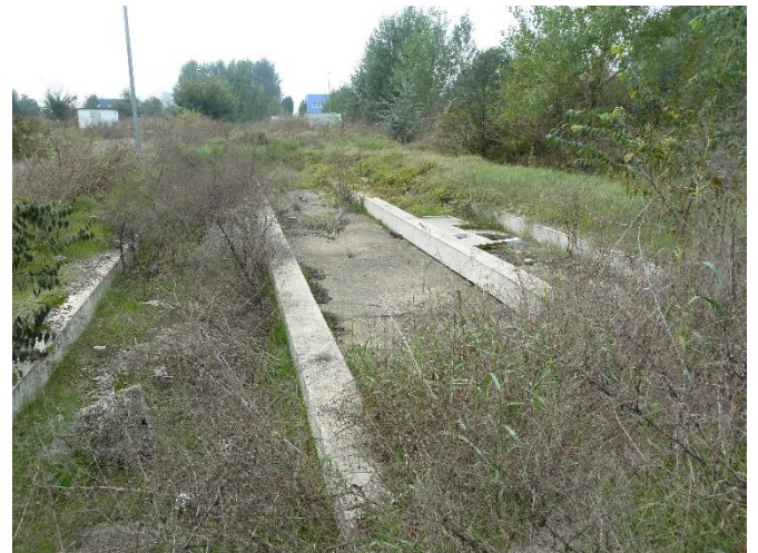
travi di appoggio per i moduli abitativi nella quadra centrale visti dalla 2' traversa verso sud
