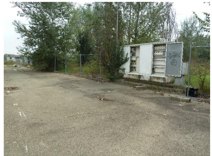
Prima traversa a nord con cabina Enel (Sx) e armadi contatori (Dx) su manufatti in c.a.
