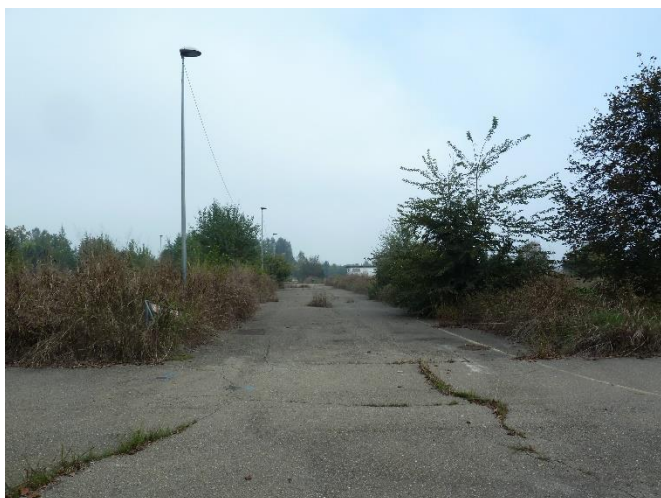
dalla 4' trasversale verso nord – a Sx la strada longitudinale secondaria: si noti la tesata aerea di alimentazione dei pali di illuminazione, mentre erano previsti cavidotti interrati - a Dx la strada esterna con parcheggio in cui risulta evidente il dislivello tra la strada e le travi di sostegno dei moduli.
