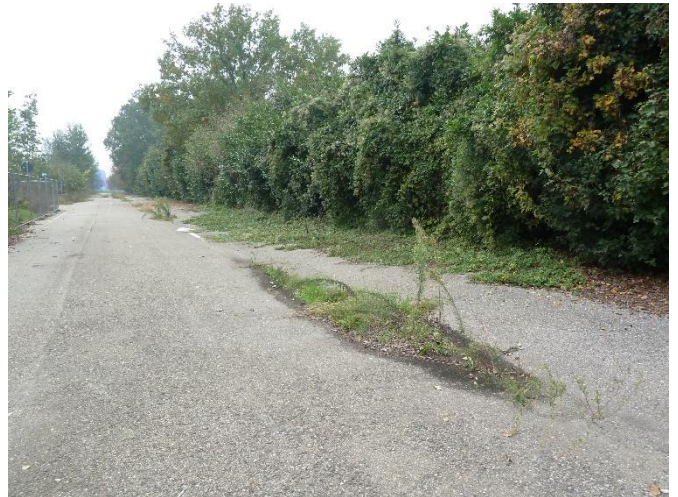
Strada principale d'accesso – le pendenze verso il centro, forse per risparmiare le caditoie laterali, ha in realtà comportato ristagni d'acqua e gelività disgreganti il manto bituminoso, favorendo la crescita di erbe infestanti.
