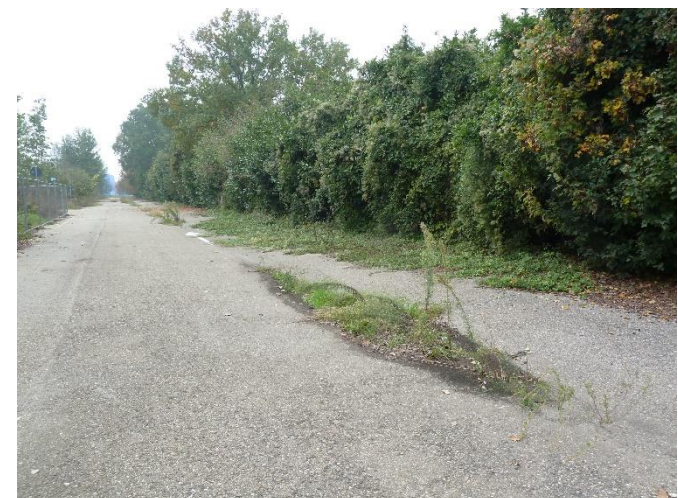
poco più avanti – si notano gli alti pioppi sempre della quadra centrale a Sx e l'affetto del compluvio centrale nella strada con il manto disgregato
