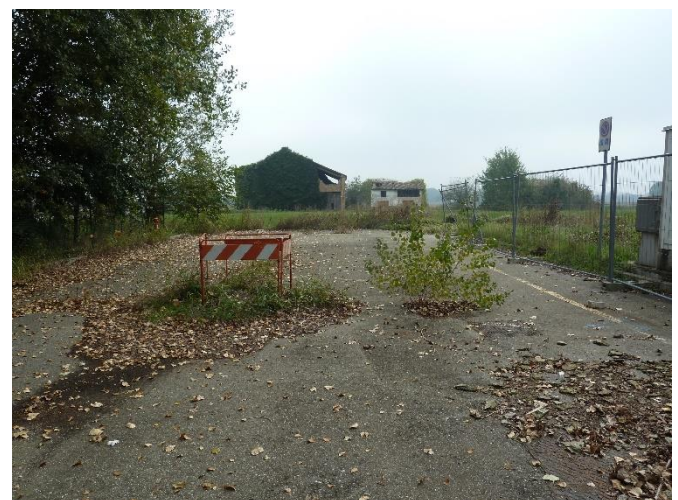
Parte finale della 1' traversa a nord – notare crescita piante entro i tombini e reti comunali residue – a Sx le piante cresciute entro la vasca di laminazione che ne rendono impossibile la manutenzione.
